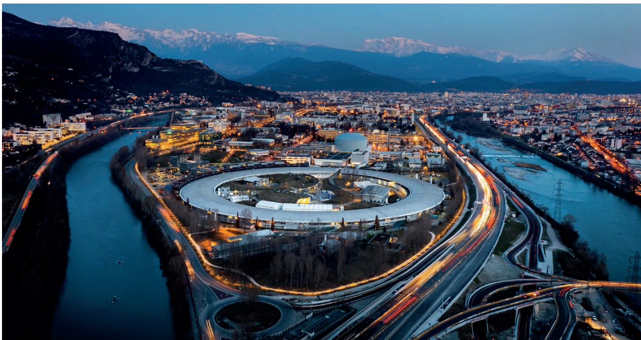
Röntgenstrahlen mit einzigartigen Eigenschaften werden bei ESRF durch hoch energetische Elektronen, die in einem Speicherring von 844 Metern Umfang zirkulieren, produziert. Bild: ESRF/VUEDICI
